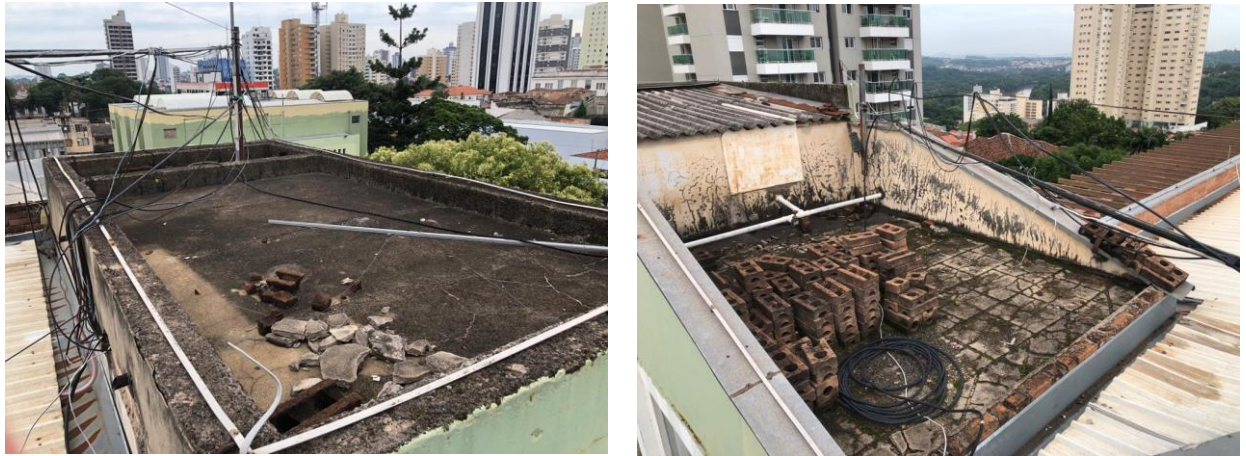
Figura 07 e 08 – Coberturas a serem impermeabilizadas.
