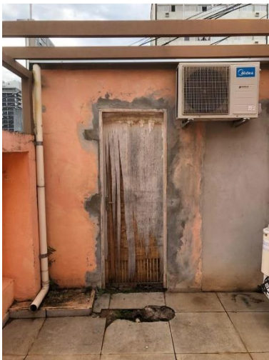
Figura 5 – Porta da casa de máquinas
