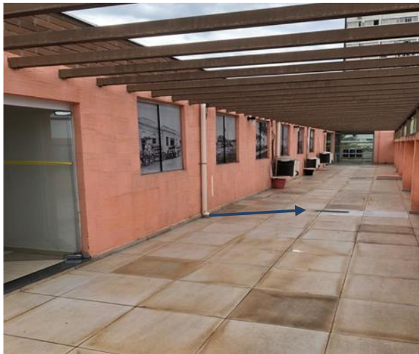
Figura 7 – Interligação do condutor ao ralo.
