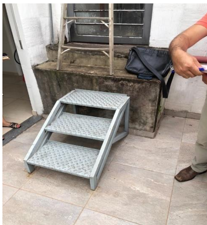
Figura 06 – Plataforma de acesso a escada da casa de máquinas
