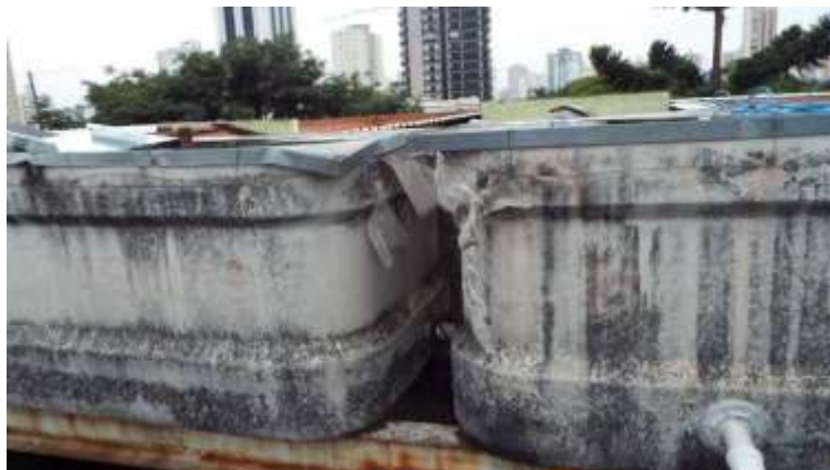
Foto 27 – Caixas d'água e instalações
